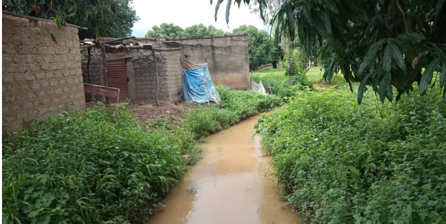
Photographie 4 : Rigole réalisée dans le vieux quartier de Bama
